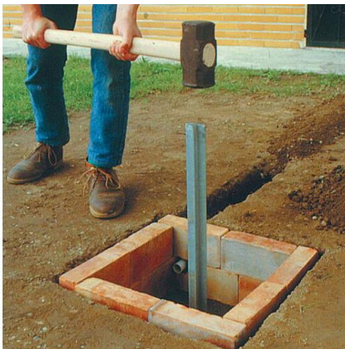
شکل (۳): نمونه‌های دیگری از الکترودهای قائم، سمت راست: الکترود لوله‌ای، سمت چپ: یک نمونه الکترود پروفیلی
